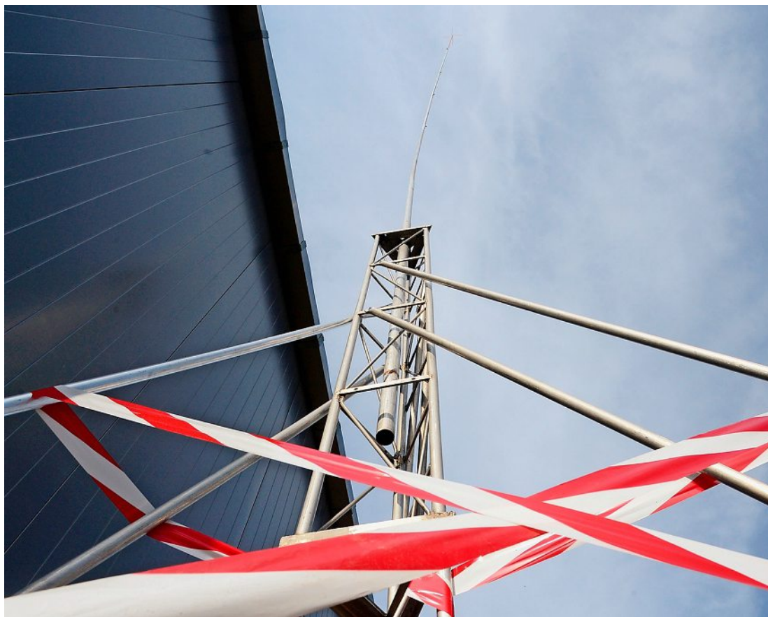
Das 24 Meter hohe Bauprofil für die Antenne hinter der Gewerbehalle im letzten Juli. Foto: Marc Dahinden
